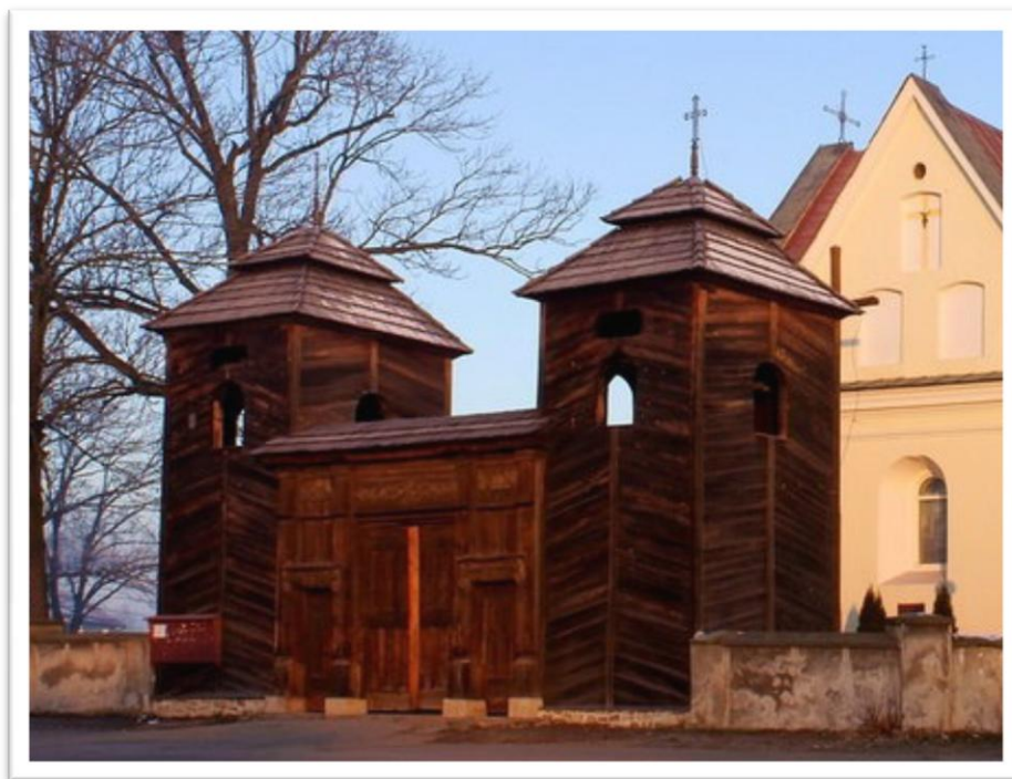
Fot. 2 Brama drewniana z dwiema dzwonicami datowana na 1779 r.
